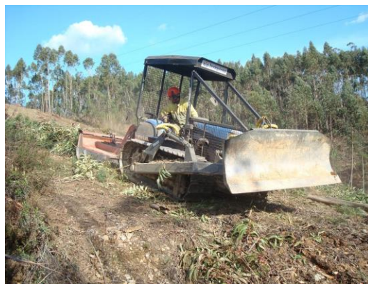
Buldózer limpando uma faixa de gestão de combustíveis num eucaliptal. Crédito fotográfico: Vasco Campos
